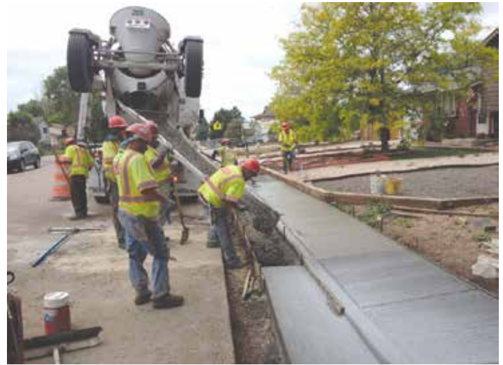
Curb and gutter pour on Burnam Street
